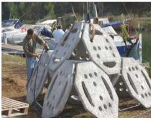
**Figura 16: Struttura di ripopolamento tipo tecnoreef**
