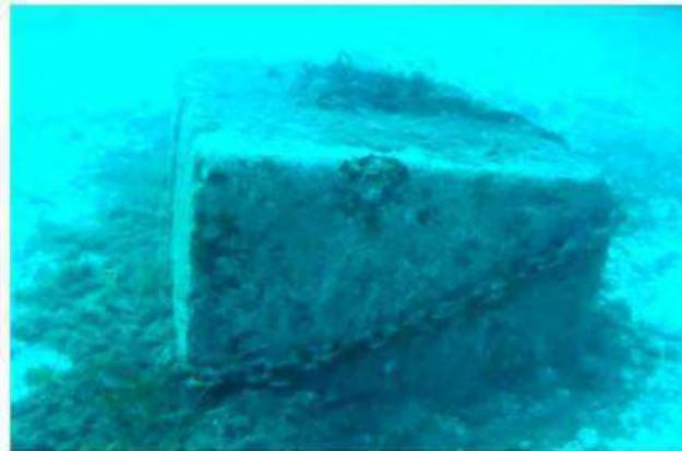
**Figura 11: Esempio di uno degli 85 blocchi di cemento (corpi morti), presente su fondale sabbioso nell'area oggetto di intervento**
