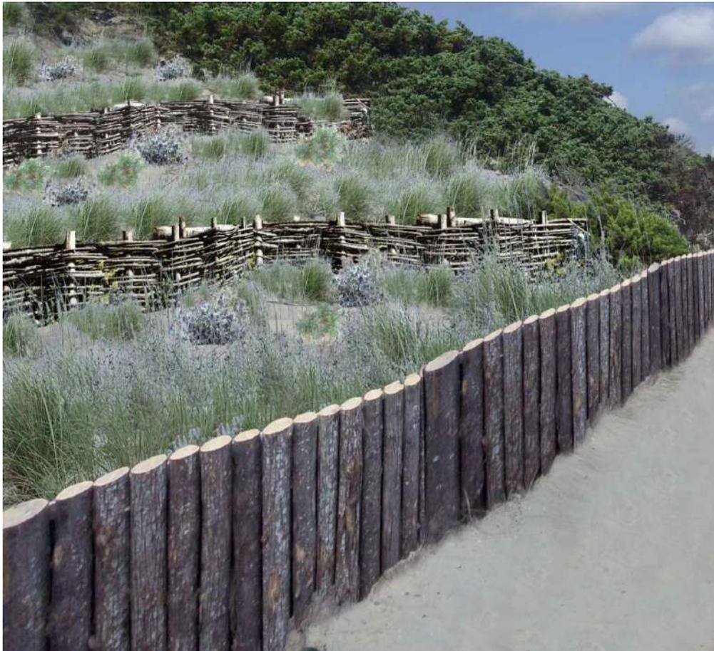
**Figura 33: Render con fotoinserimento del sistema di protezione dunale con palizzata bassa al piede del primo cordone dunale, graticciate e restauro vegetazionale**
