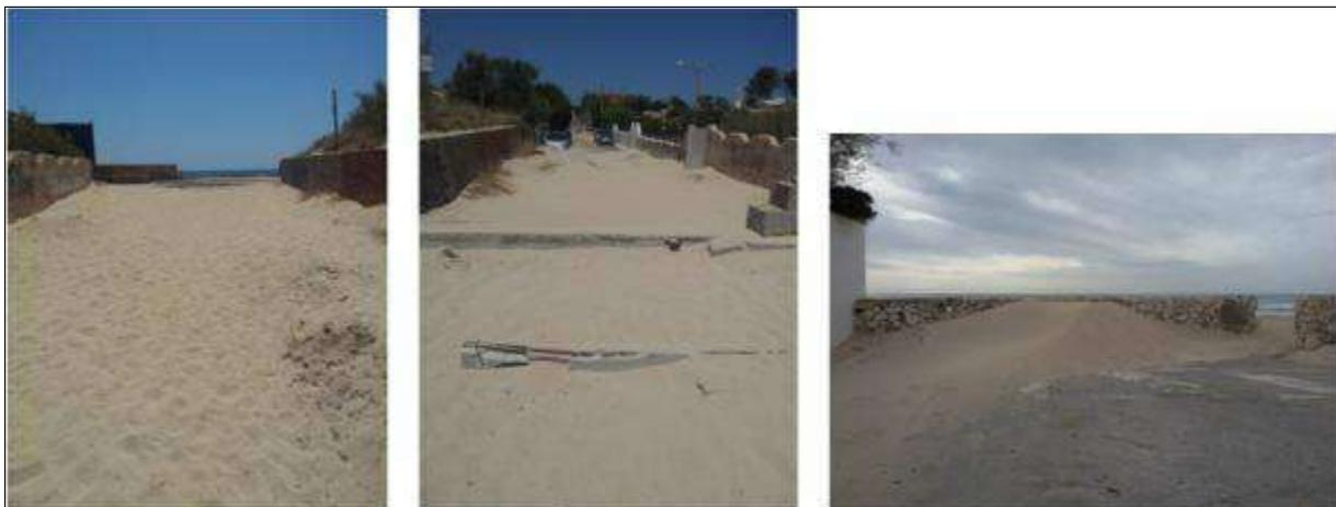
**Figura 29: Esempi di vie stradali che terminano sulla spiaggia. Da questi “varchi”, per azione del vento, si determina una notevole dispersione di sabbia nel retro spiaggia urbanizzato**
