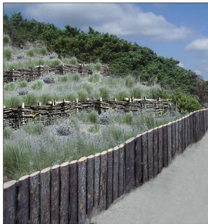
Ricostruzione fotografica del sistema di difesa e consolidamento della duna con palizzata e graticciata
